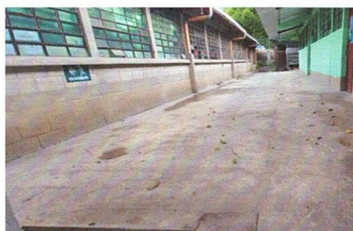
Foto 4: LOSA DE PATIO FINALIZADA
