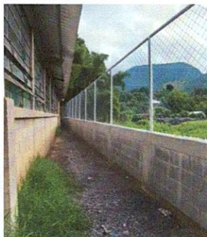
MURO DE CONTENCIÓN
