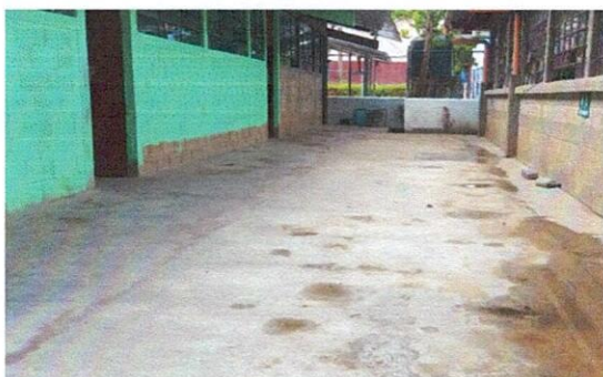
Foto 3: LOSA DE PATIO
